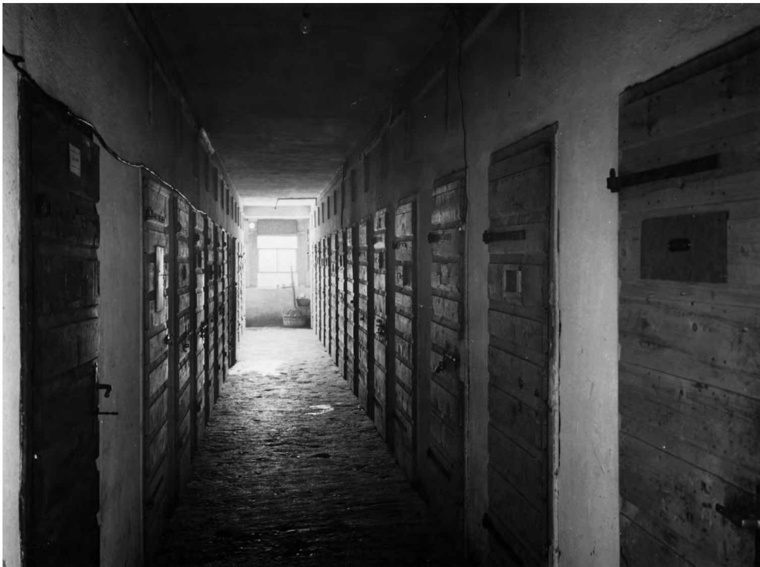
Immagini del campo di transito di Bolzano nel quale fu imprigionato Egidio Meneghetti nel 1945. Vista delle celle. Rimase in funzione tra la fine del 1943 e il 1945.
